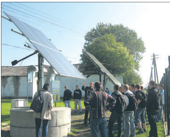
Kolektory słoneczne, czyli dobra energia.
