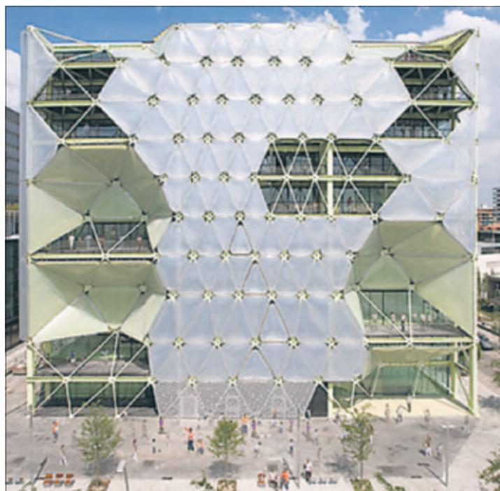
Media ICT to niezwykle oryginalny i ekologiczny budynek. Tym zdobył uznanie podczas Światowego Festiwalu Architektury w Barcelonie.
